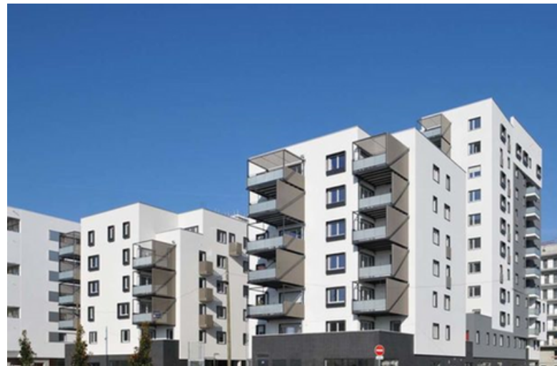
IMMEUBLE AFRILAND, LIBERTE VI 01 Ascenseur 630 kg / R+6
