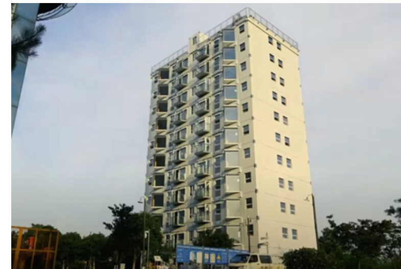
IMMEUBLE KAKORO, NGOR VIRAGE 01 Ascenseur 630 kg / R+10
